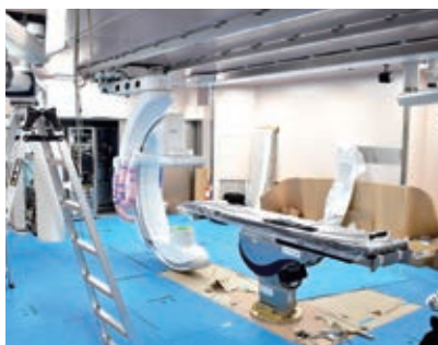
ハイブリッドOP室 ※現在工事中
