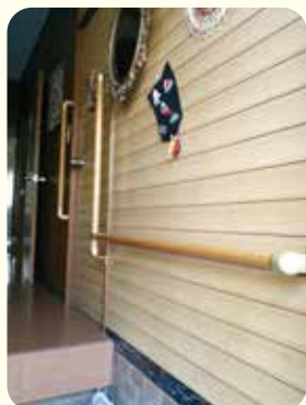
縦手すりと横手すりを設置されています。
